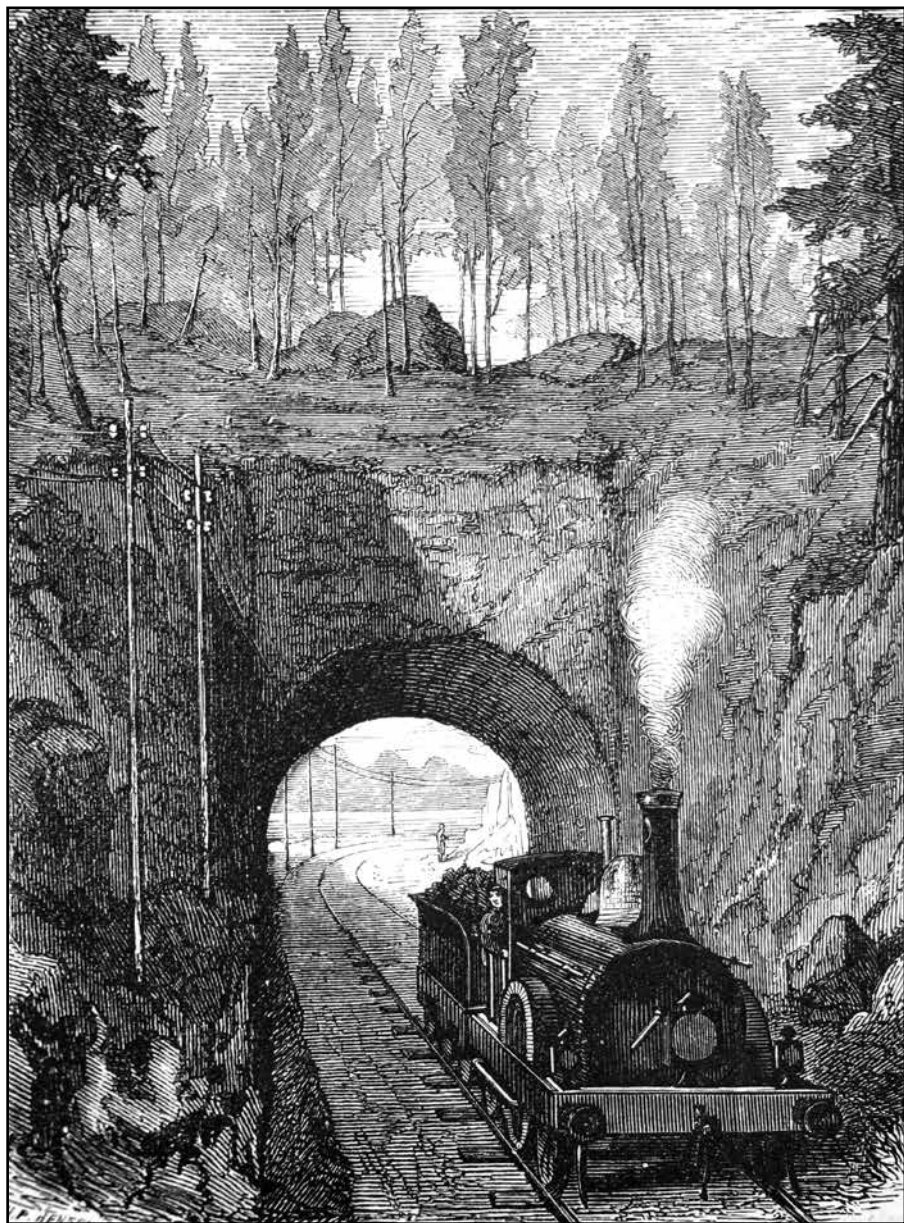
Bild 10. Från östra stambanan: Stens tunnel.
