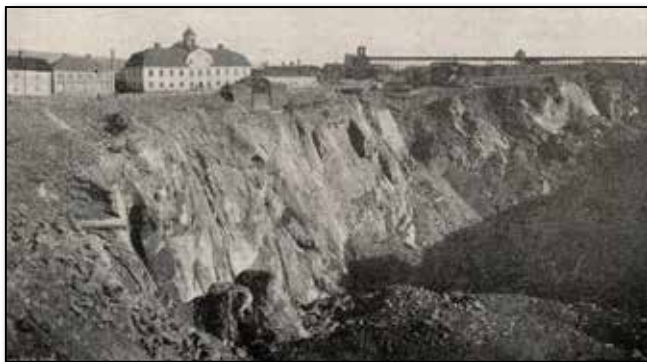
Falu grufva: Stora stöten. Den större byggnaden är »Grufstugan» och den mindre, vid stötens brädd, »Anfarten», (nedgångsöppningen). Till höger »Creutz' schakt» med den på bockar uppbyggda vattenledningen för »konst- och spelhjulen» vid Creutz.
